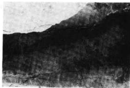
fig.25 SD-01 断ち割り状況
