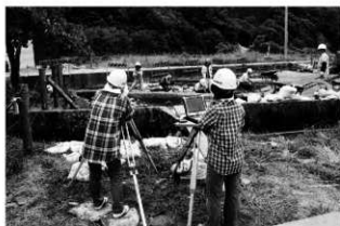
電子平板での測量作業
