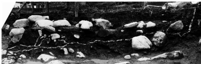
堤防断面 b-b' オルソ画像
