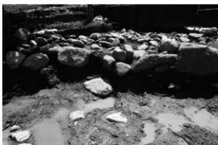
川裏側法先部分石列
