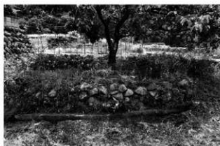
調査区東側に残る堤防跡 (川裏側から)
