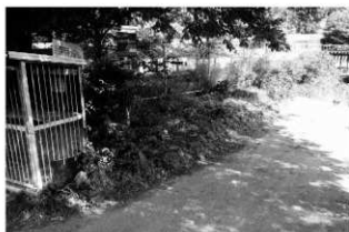
北東へ 200 m ほど離れた地点に残る堤防跡
