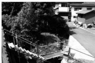
北東へ 100 m ほど離れた地点に残る堤防跡
