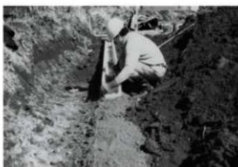
排水工 U型側溝敷設
