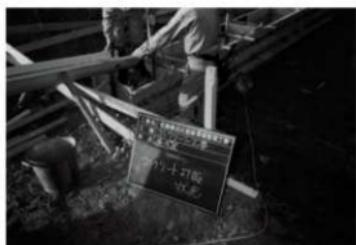
東屋 基礎コンクリート打設
