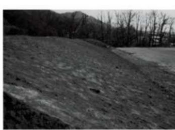
高さ 0.9m、天端幅 0.6m、法面傾斜角度は  $\angle 70^\circ$  程度とした。
