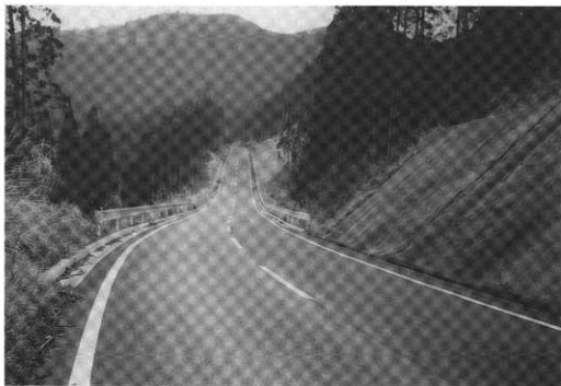
工事後の谷合第2遺跡（北から）
