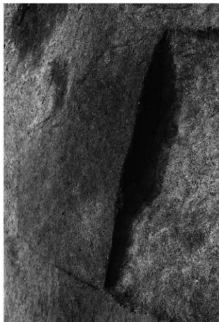
③ SK03断面 (北東から)
