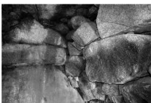
写真12 奥壁と左側壁の持ち送り
