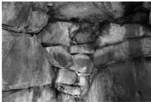
写真11 奥壁と右側壁の持ち送り
