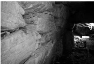
写真 31 玄室左側壁 奥壁から
