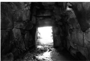
写真13 奥壁から玄門部を見る
