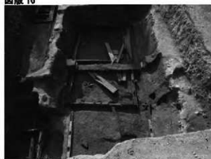
1. II区下層 建物 15・20 (東から)
