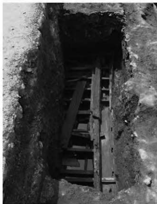
1. II区下層 建物19 (東から)
