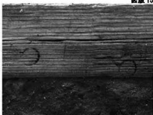
4. II区下層 建物11南辺土台材アップ(北から)
