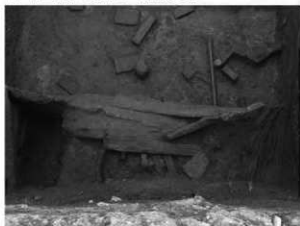
2. I区下層 建物3南辺壁倒壊状況 (北から)
