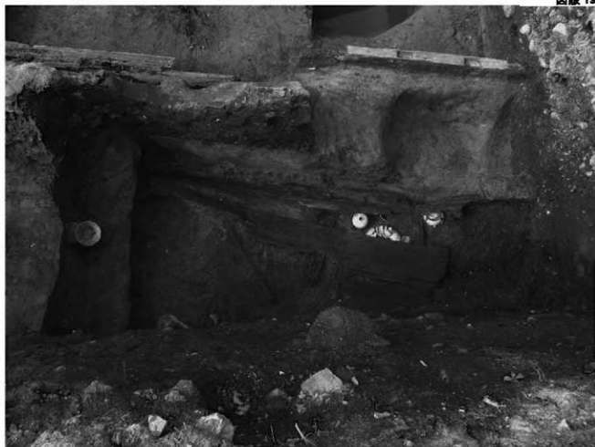
1. II区下層 建物 21 北辺壁板倒潰状況 (南から)
