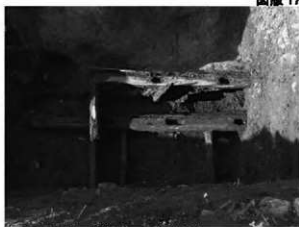
3. II区下層 建物17・21 (南から)
