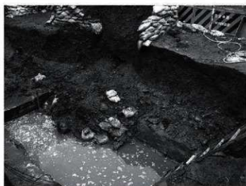
▲ 4. 崩落状況 (南東から)
