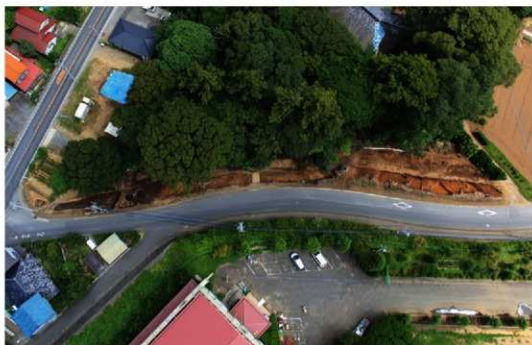
調査区全景（西上空から）
