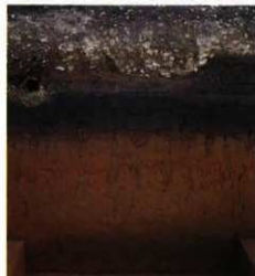
▲ 土層断面写真
