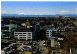
▲ 国分寺駅ビルより調査区を臨む
