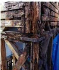
▲塔屋隅柱の腐朽
