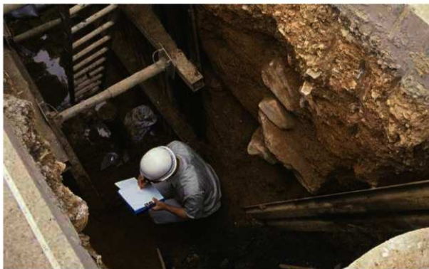
工事掘削面に現れた石積みの実測
