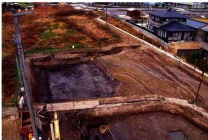
写真 54 SR06・07 掘削状況 (東から)
