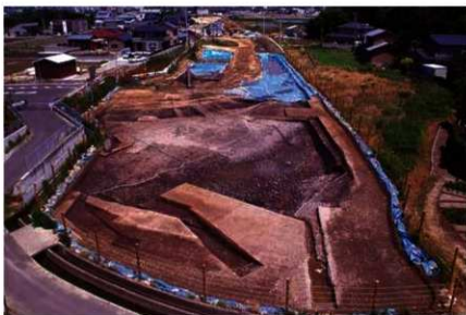
写真 56 SR06 掘削状況 (西から)
