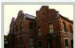
⑰ 平安女学院明治館 明治27年(1894) 国登録有形文化財 (上京区下立売通南町西入五ツ町)
