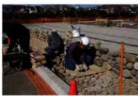
写真 34 雨落ち石敷きの施工
