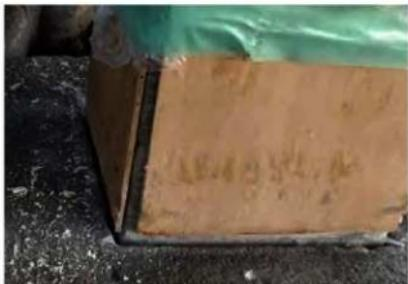
標柱と台石の隙間に詰め込まれていたモルタル
