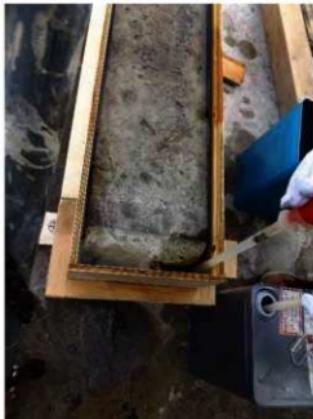
石が完全に浸った後、箱表面にポリエチレンシートを被せ強化剤の蒸発防止目減り具合などを時々点検する。（右）
