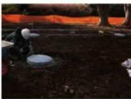
①砂で養生した後に埋戻した磐石(A1-2・B2-2)
