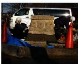
⑧基壇設置・最下段モルタル造形
