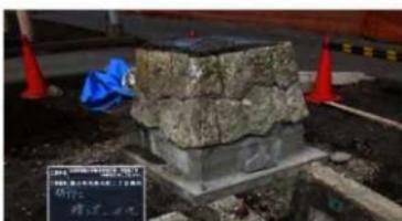
1、2段目組立完了（この中にはコンクリートが充填されている）
