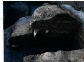
▲中樞部区画施設北西地区 築地層基礎部分の断り状況 基礎部は黒色土で、その上に粘質の褐色土と白色粘土・砂質土を、固く叩き締めたが積み上げている状況が判ります。
