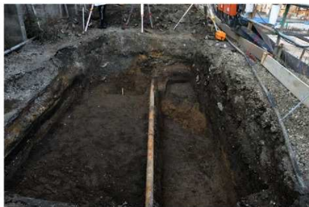
1A 区 SH1001 底面完掘状況 (南より)
