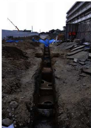
2A区 完掘状況 (南より)
