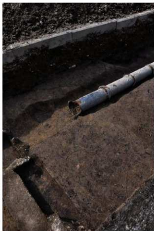
3B区 SB3001 柱穴検出状況 (東より)
