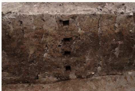
7-10 区 SR01 土層断面 b-b' 土壌サンプル資料採集状況 (東より)
