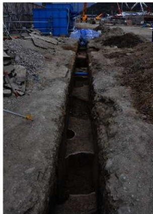
2A区 完掘状況 (北より)
