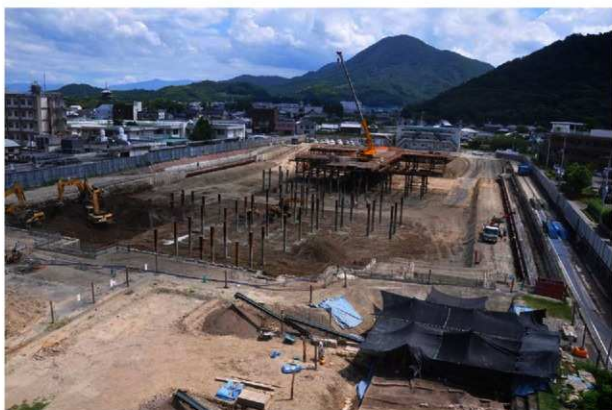
4区 付近調査風景（北より）
