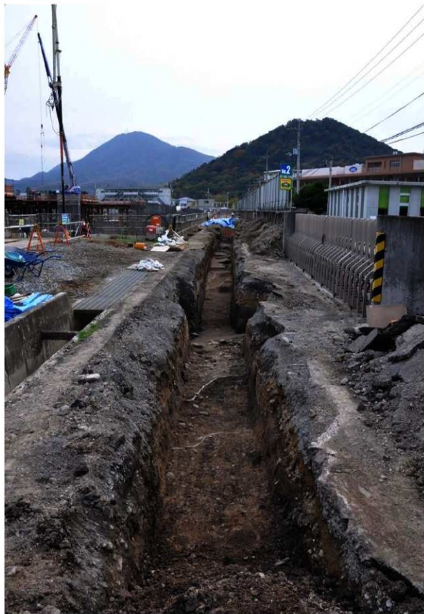
第30次調査1E区 完掘状況（北より）
