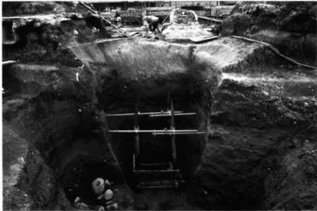
図41 井戸2. 掘方の断ち割り状況。西向きに撮影。左に井戸3の掘方の一部が残る。
