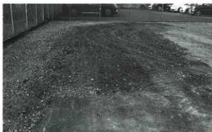
調査区埋戻し状況 (南から)
