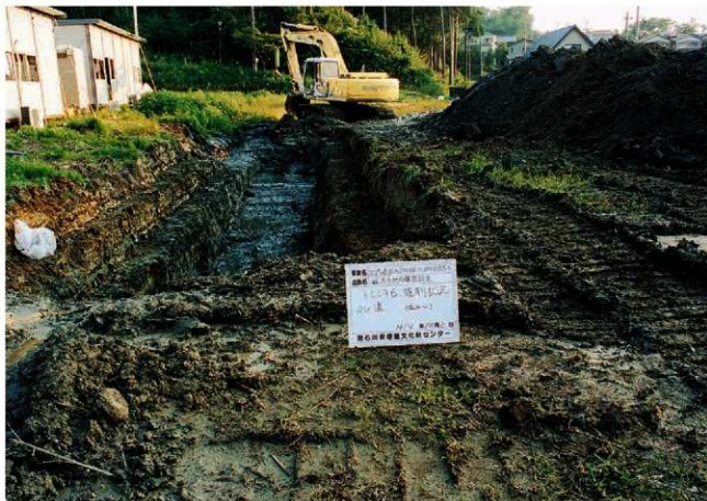
トレンチ6 掘削状況
