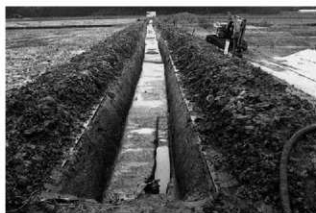
B区完掘状況（北西から）
