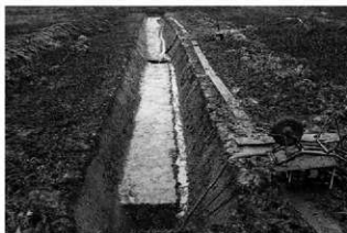
調査区完掘状況（北西から）
