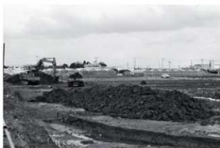
調査区埋め戻し作業 (南西から)
