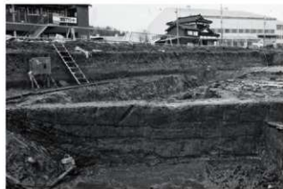
4号溝 土層断面 (南東から)
