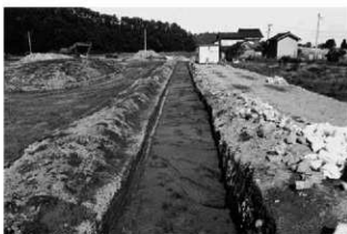
B1～8区 遺構完掘状況（南から）
