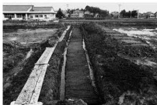
A区 遺構検出状況（西から）
