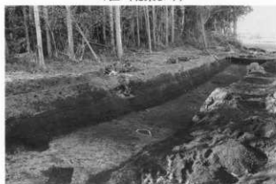
6区北半 (南東より)
