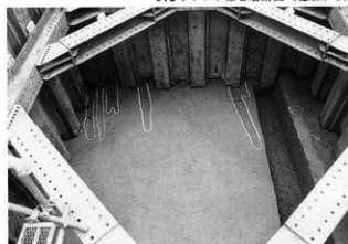
2.2 トレンチ第III-2面溝完掘状況 (西から)
