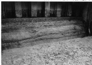
3.1 トレンチ第II層断面 (北東から)
