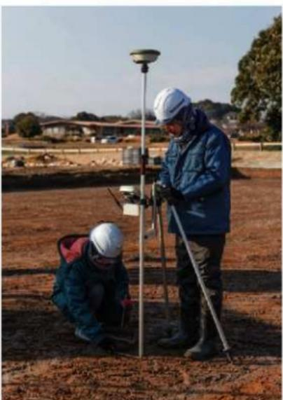
사진1 GPS를 이용한 평면 좌표 기록.
