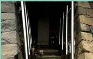
大天守出口安全対策 H31(2019)2月
