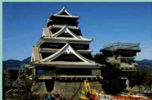
工事の状況 H31(2019)1月
