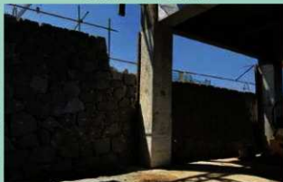
小天守内部石垣積み直し H31(2019)2月
