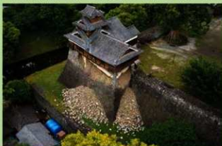
被災状況 H28(2016)4月
