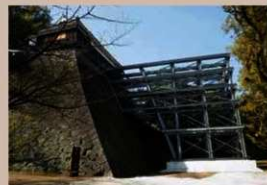
鉄骨仮設構台設置終了 H31(2019)2月
