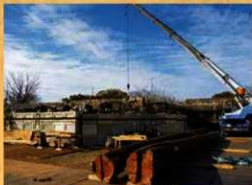
西大手門解体 H31(2019) 1月
