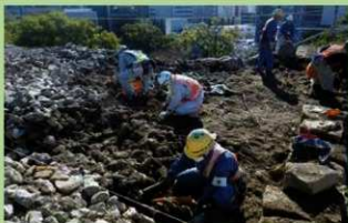
石垣裏グリ石解体 H30(2018)11月
