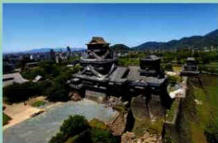
被災状況 H28(2016)4月
