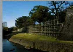
復旧工事中 H31(2019)3月
