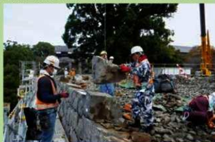
石垣解体作業 H30(2018)11月
