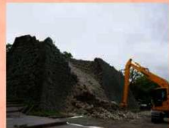
崩落石材回収作業 H30(2018) 5月
