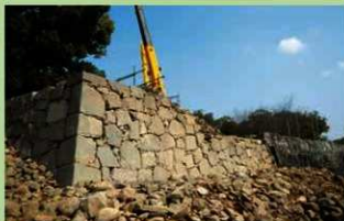
埋没石垣検出状況 H31(2019)3月
