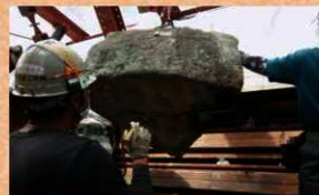
築石尚土の接点確認作業状況 (令和2年10月19日)
