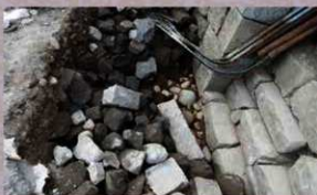
根石・基礎部確認状況 東から (令和2年12月21日)
