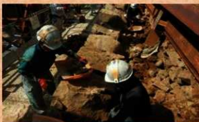
解体作業状況 (令和2年10月5日)
