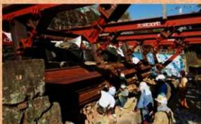
土留め矢板設置作業状況 (令和2年10月5日)
