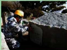
彫取り作業(令和3年1月14日)
