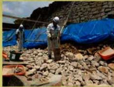
裏込め締固め状況 (令和3年6月24日)
