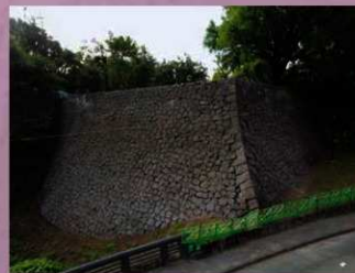
復旧完了状況 (令和3年10月8日)
