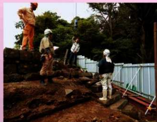
崩落石材回収状況 (令和3年7月12日)
