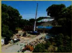
要人櫓台石垣造営 (令和3年6月21日)
