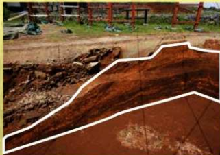
平左衛門丸造成時の版築状盛土 (白枠部分)
