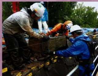
石垣積み直し状況 (令和3年9月14日)
