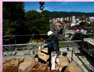
石垣解体状況 (令和3年8月4日)
