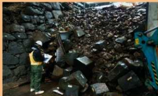
小天守内側石垣崩落石材蓄積作業
