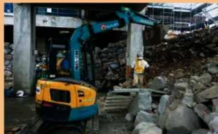
小天守内側石垣崩落石材回収作業
