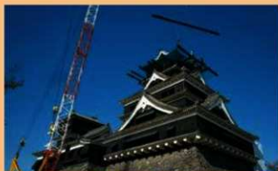
H29.4.14 天守閣工事 西より
