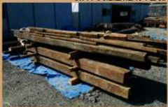
仮設倉庫に格納
