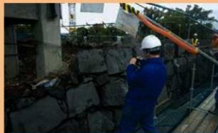
小天守石垣解体前写真記録作業
