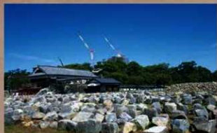
崩落した石材の保管
