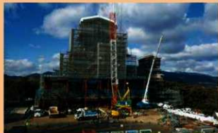
H30.1.26 天守閣工事 東より
