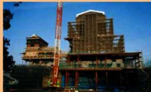
H30.2.20 天守閣工事 西より
