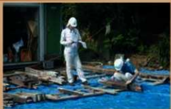
部材対照作業
