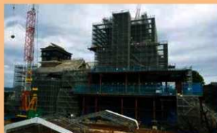
H29.10.27 天守閣工事 西より
