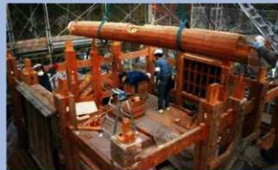
建物部材回収作業
