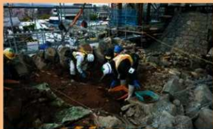
小天守石垣解体作業（裏込め掘削）
