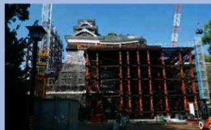
H29.10.27 下からの構台を建設後、上の構台を撤去 南より
