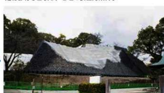
建物部材を回収し、石垣の安全対策終了
