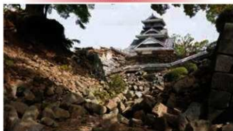
③類当御門周辺 通路両面の石垣崩落
