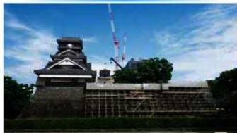
続櫓部材回収のため足場設置工事中
