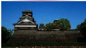
①宇土櫓 続櫓部分が倒壊
