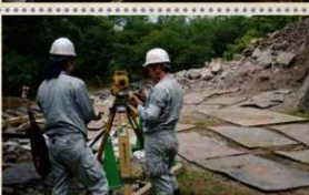
堀石垣測量作業
