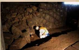
大天守内堀の垣根打ち、番付作業
