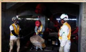
大天守内堀土留石組取作業
