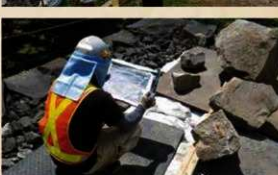
被覆設置による石垣取作業
