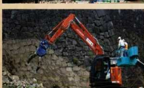
無人化作業による石垣の回収
