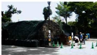
石垣石材を回収し、安全対策終了
