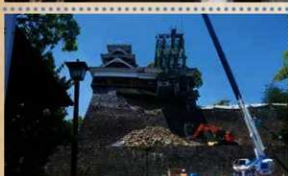
堀石垣の回収作業
