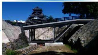
石垣養生工事終了。スロープは天守工専用仮設通路。
