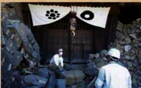
小天守入り口付近石組取作業
