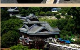
飯田丸土留壁取作業(平成29年14月分)
