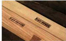
補修材に付けられた修補年の焼印(令和4年2月18日)
