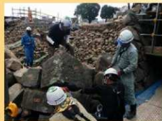
解体作業は慎重に進めました
