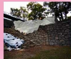
石材回収完了(令和4年3月)
