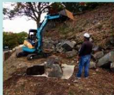
栗石回収作業状況(令和3年11月)
