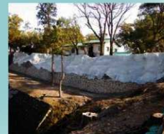
石材回収完了(令和4年3月)
