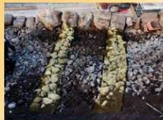
石垣の後ろの構造をよく観察すると、列状に並ぶが見えます
