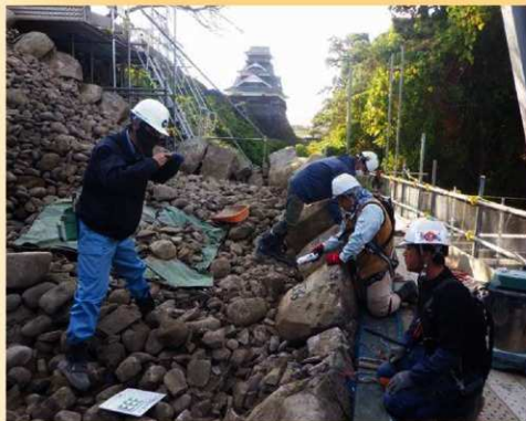
1石解体ごとに石同士の間隙や積み方を記録します
