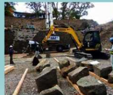
栗石仮置き状況(令和3年11月)
