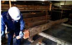
部材の補修作業(令和4年1月31日)
