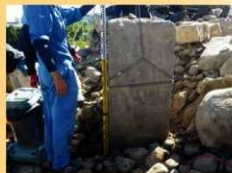
昭和29年に設置された1mを超える高さのコンクリート基礎
