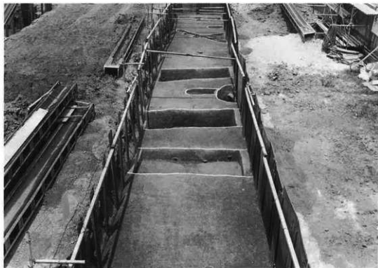
1. A地区道桥全景
