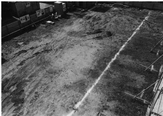
1. 調査前の状況
