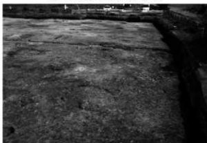
調査区完掘南側（西から）
