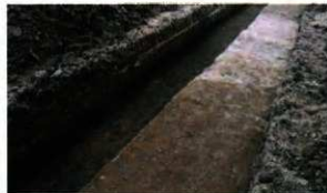
写真13 2Tセクション (北西から)
