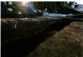
写真34 SB3c地業土層断面 (A-A'セクション)
