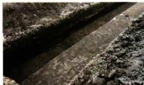
写真12 1Tセクション (北西から)
