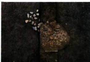
写真30 SB3a・b礎石据え付け地業・根固め (西第2柱列北第3柱)
