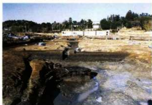
3 1号溝断面(全体)
