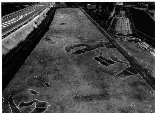
2 E区北 全景 (南東から)
