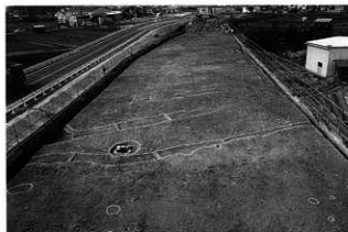
3 V区 全景 (南東から)
