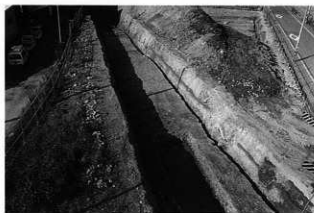
1 S区 大溝1 (南東から)
