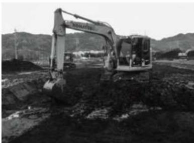
写真1 表土除去作業（1-2区）
