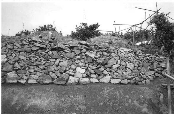
b 東側石垣南端部1 東から
