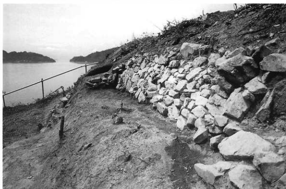
b 東側石垣南端部 スロープ状平坦面 北東から
