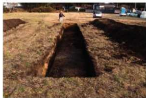
写真84 2T調査状況
