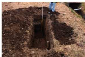
写真91 1T調査状況
