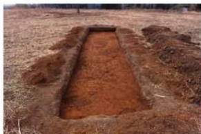
写真76 3 T調査状況
