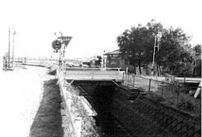
川俣宿はずれ利根加用水 (旧上休泊堰)
