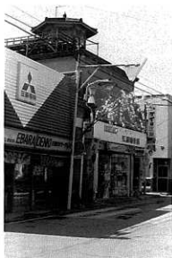
富岡市内 旧消防望楼
