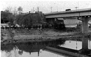
富岡東 甘楽橋(三代の橋の変遷がわかる)
