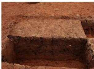
SR1 土層伏況(北東から)
