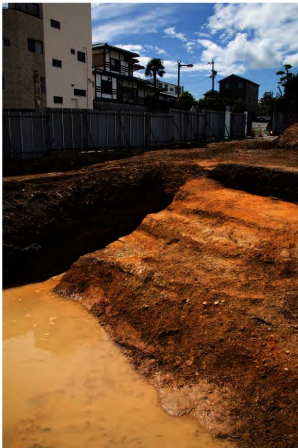
40次調査区2 全景（北東から）
