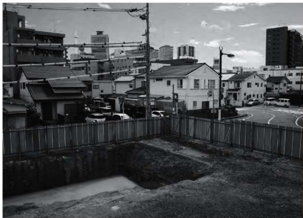
4 調査区2 完掘状況 (北西から)
