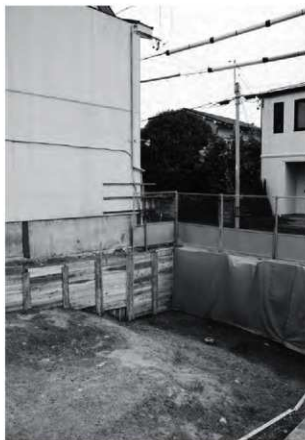
1 調査区1 完掘状況 (南西から)
