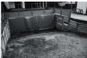
2 調査区1 完掘状況 (北西から)
