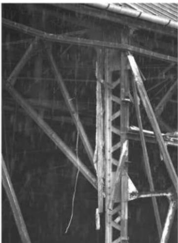
写真 15 屋根部トラスと側面鉄筋との接続部
