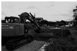
1次面重機表土除去作業
