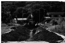
2次面重機表土除去作業
