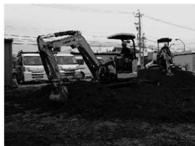
重機表土除去
