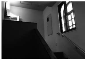
竣工 4 内部 (1階階段・北から)
