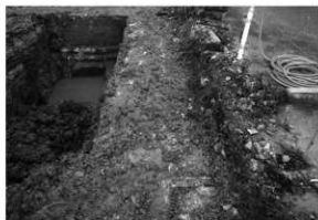
解体工事 3 地中のレガ積・コンクリート基礎 (南東隅)
