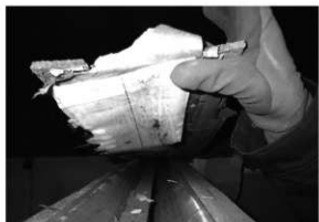
解体工事 39 間仕切に隠れた旧天井 (2階北西部)
