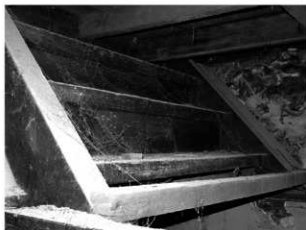
写真 3-23 残存した階段 (1階南東部・南西から)
