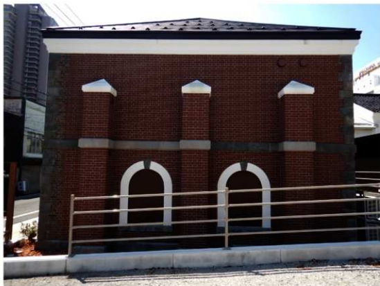
3 竣工 側面（北面）
