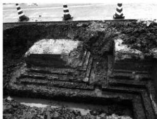
写真 3-2 地中の独立基礎 (北面東側・南から)
