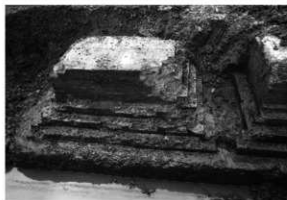
解体工事 6 同 (北面東側・南から)
