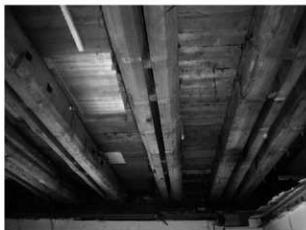
写真 3-14 2階床梁の構造（中央・南から）
