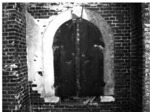
写真 3-21 鉄扉(外壁西面1階・南側)
