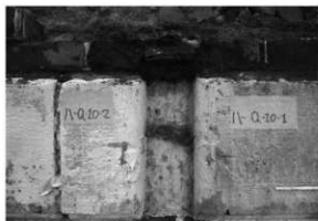
解体工事 36 同 (北面・東から2つ目)
