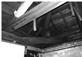
解体工事 27 小屋組・火打ち梁 (南西隅)
