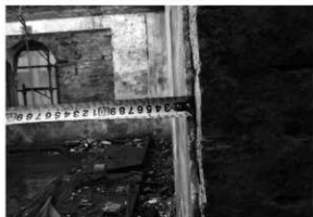
解体工事 46 同 (西面2階・北から)
