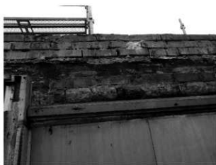
写真 3-26 天井廻り縁（西面 2階・北側）
