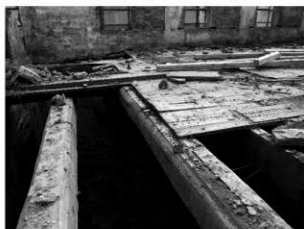
写真 2-6 2階床組解体状況 (東側・北から)
