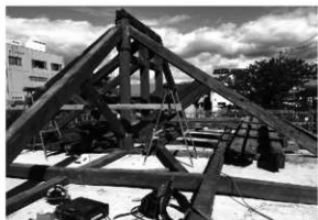
小屋組設置工事 1 (南東から)
