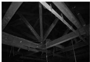
解体工事 23 小屋組トラス（南西から）
