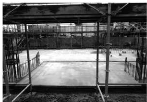
基礎工事 1 (東から)
