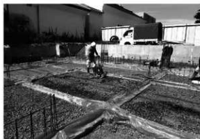
土工事 1 (北東から)
