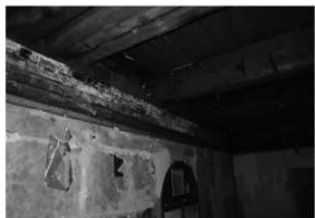
解体工事 43 天井蛇腹の跡 (南面1階・北東から)
