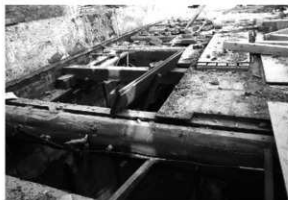
解体工事 22 2階床組（西側・西から）
