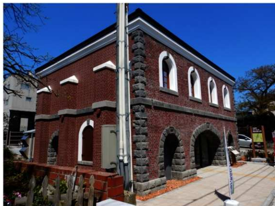
2 竣工 正側面（南東面）
