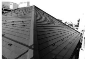
屋根工事 2 ガルバリウム鋼板葺き (北東から)
