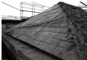
解体工事 32 棧瓦下の土葺き・野地板 (北東から)
