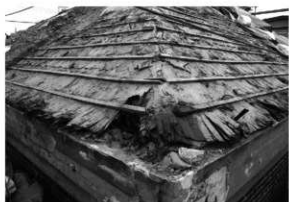
解体工事 33 棧瓦下の土葺き・杉皮 (南西から)
