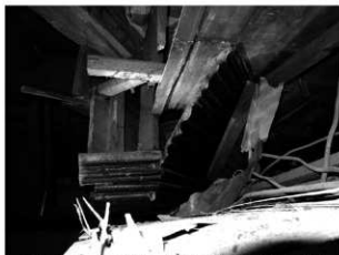
写真 3-25 天井蛇腹 (1階南東部・北東から)
