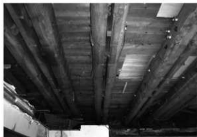
解体工事 18 同（中央・北から）
