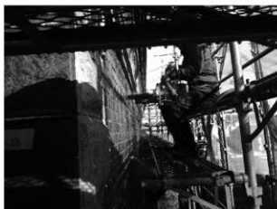
写真 2-2 レンガ解体状況 (外壁東面・南から)
