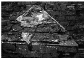
解体工事 11 バットレス頂部 (外壁東面中央)
