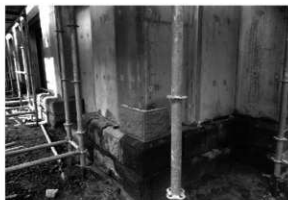
石工事 1 基礎・隅石 (北東から)
