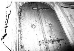
解体工事 37 鉄扉内側 (西面1階・北側)
