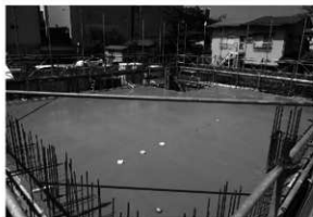
コンクリート工事 1 2階床梁 (南東から)
