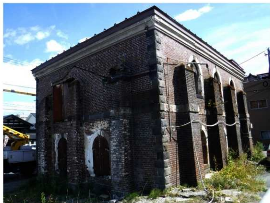
8 移築前 側背面（南西面）
