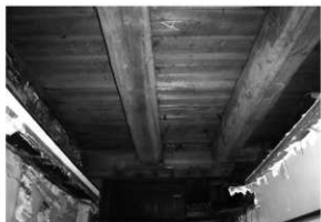
解体工事 19 同（東側・北から）
