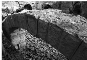
解体工事 16 中央アーチ (北面1階・北西から)
