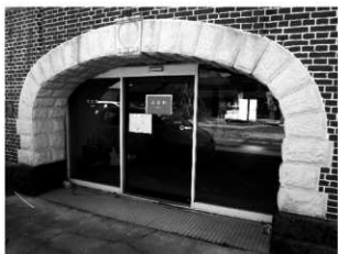
写真 3-10 正面1階中央アーチ (外壁北面)
