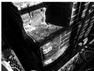
写真 3-7 隅石設置状況 (外壁南西隅)
