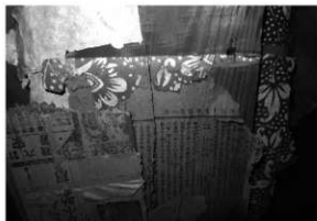
解体工事 40 旧天井の裏張り新聞 (明治35年)
