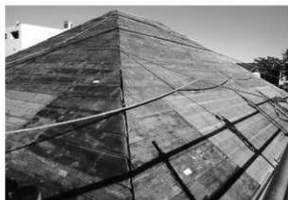
屋根工事 1 野地板 (北西から)
