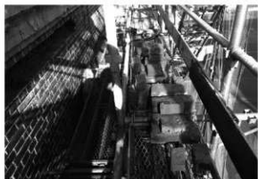
解体工事 9 躯体レガ取外し (東面2階・南から)
