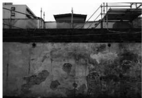
解体工事 45 砂漆喰・漆喰の内装 (東面2階・西から)
