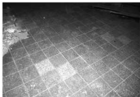
解体工事 48 1階タイル張りの床
