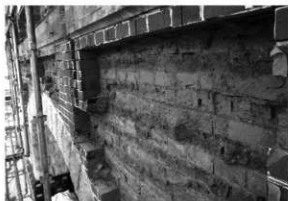
解体工事 10 同 (北面2階・北西から)
