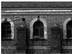
写真 3-9 擬蛇腹石 (外壁南面の胴蛇腹)
