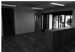
竣工 1 内部 (1階・南西から)
