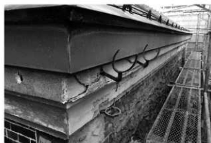
写真 3-22 雨樋の受け金具（外壁東面・南から）
