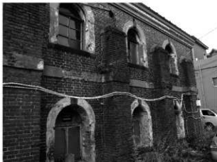
写真 3-28 躯体レンガ（外壁南面・南西から）
