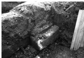
解体工事 5 同 (西面中央バトリス外側・北西から)
