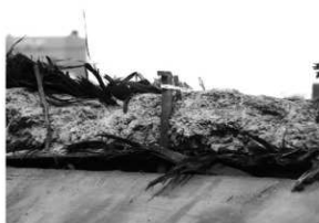
解体工事 34 棟頂部の鉤状金具 (南から)
