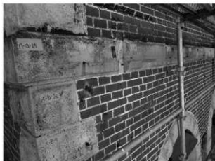
写真 3-8 胴蛇腹設置状況 (外壁北面・北東から)
