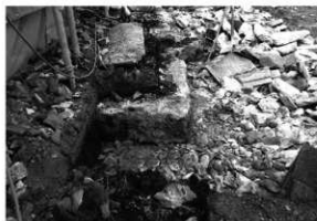
解体工事 2 同 (南面中央・東から)
