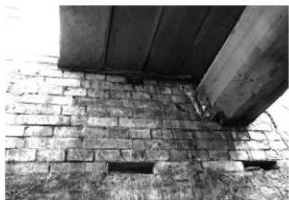
解体工事 21 2階床梁・東壁の接続（中央・西から）
