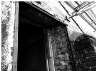
写真 3-5 後年の開口部・拡大（外壁西面2階） (2) バットレス
