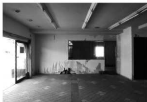
移築前 1 内部 (1階・西から)
