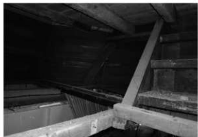
解体工事 41 階段周りの装飾板 (1階南東部)
