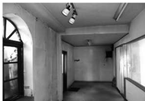
移築前 4 内部 (1階東側・北から)
