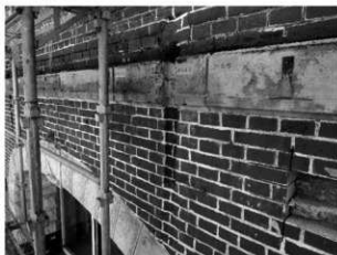
写真 3-19 バルコニーの痕跡 (外壁北面・西から2丁目)
