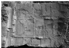
解体工事 14 躯体レガ長手1枚取外後 (北面1階)
