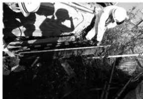
解体工事 8 地中コンクリート基礎下の杭木
