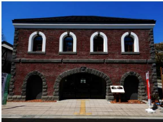
1 竣工 正面（東面）
