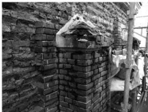
写真 3-6 バットレス (外壁東面中央・南東から)
