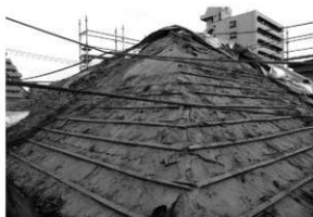
解体工事 31 棧瓦下の土葺き (南西から)
