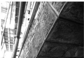
石工事 2 正面中央アーチ上部 (東面 1階)
