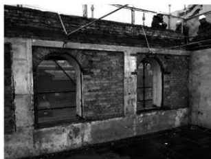
写真 3-13 内部壁面（北面2階・東側）
