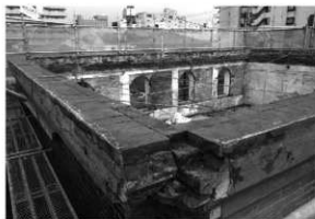
解体工事 12 小屋組解体後 (南西から)
