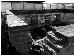
写真 3-3 躯体レンガ（外壁東面2階・北から）
