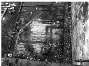
写真 3-24 階段の開口部跡 (2階床面・南東部)
