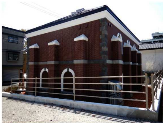
4 竣工 側背面（北西面）
