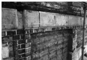
解体工事 35 パルコ-跡・金物 (北面・西から2つ目)
