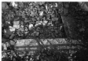
解体工事 1 地上部の土台石 (南西隅)
