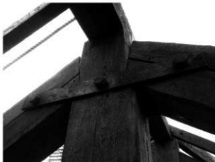
写真 3-16 緊結部の加工ボルト
