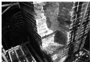
解体工事 15 隅石取外し (南西隅)
