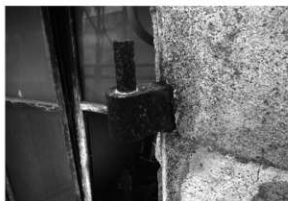
解体工事 38 鉄扉蝶番の痕跡 (南面2階・東窓)
