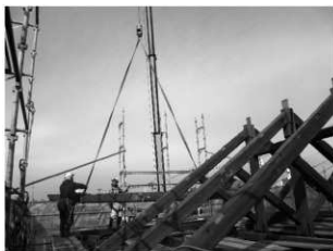
写真 2-4 小屋組解体状況 (西桁・東から)
