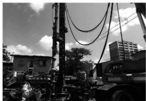
杭工事 1 (南から)
