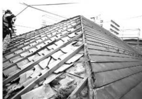
解体工事 30 同 (西面・南西から)
