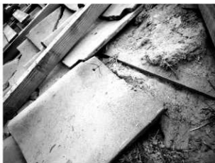
写真 3-18 瓦葺きの状況 (西面・南西から)
