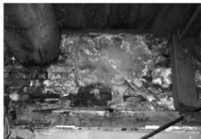
解体工事 42 階段(右)と旧ササ跡 (1階東壁・南東)
