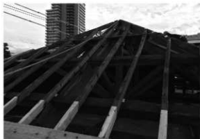
小屋組設置工事 2 (北西から)
