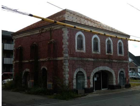
6 移築前 正側面（北東面）
