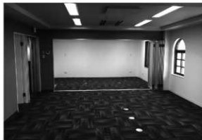
竣工 6 内部 (2階・南から)
