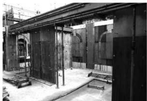
型枠工事 1 1階内部 (南東から)
