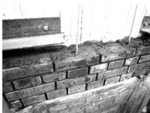
写真 2-8 既存レンガ添え積み状況（外壁東面）
