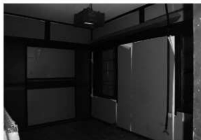
移築前 6 内部 (2階北西側・南東から)
