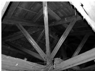
写真 3-17 木造洋式トラス組（西側・南西から）
