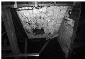
解体工事 28 小屋裏の内装 (南東部・南から)
