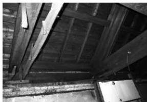
解体工事 26 小屋組端部 (西壁・南東から)
