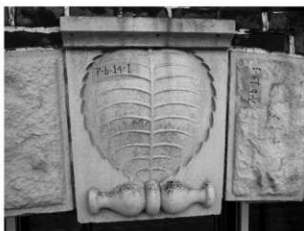
写真 3-11 同アーチ要石の彫刻（外壁北面）
