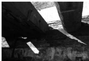
解体工事 20 2階床梁・北壁の接続（東側・南から）
