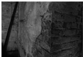
解体工事 47 同 (西面1階・北から)
