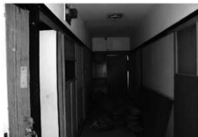
移築前 8 内部 (2階中央部・東から)
