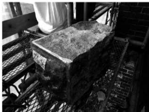
写真 2-3 石材解体状況 (外壁南西の隅石)
