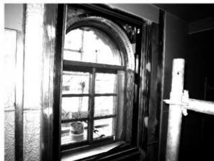
写真 2-7 復原した窓・窓枠（西面2階・北側）
