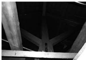
解体工事 25 小屋組トラス (中央・東から)
