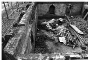
解体工事 13 2階床梁解体後 (東から)
