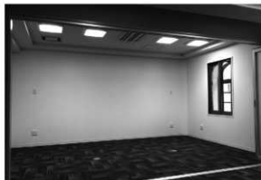
竣工 7 内部 (2階・南西から)
