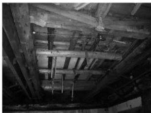
写真 3-15 後年の改造跡（西側・北から）
