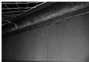
解体工事 44 天井廻り縁 (西面2階・北東から)
