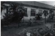
昭和31年に新築したブロックの校舎（撮影は昭和40年頃） 写真提供：土屋二郎氏
